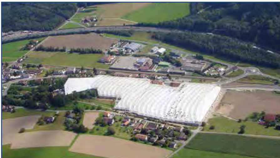
Полигон SMDK, вид сверху до возведения крыши
