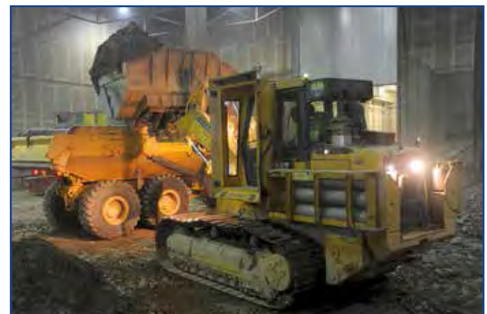
Работы по выемке отходов с полигона SMDK проводились внутри здания
