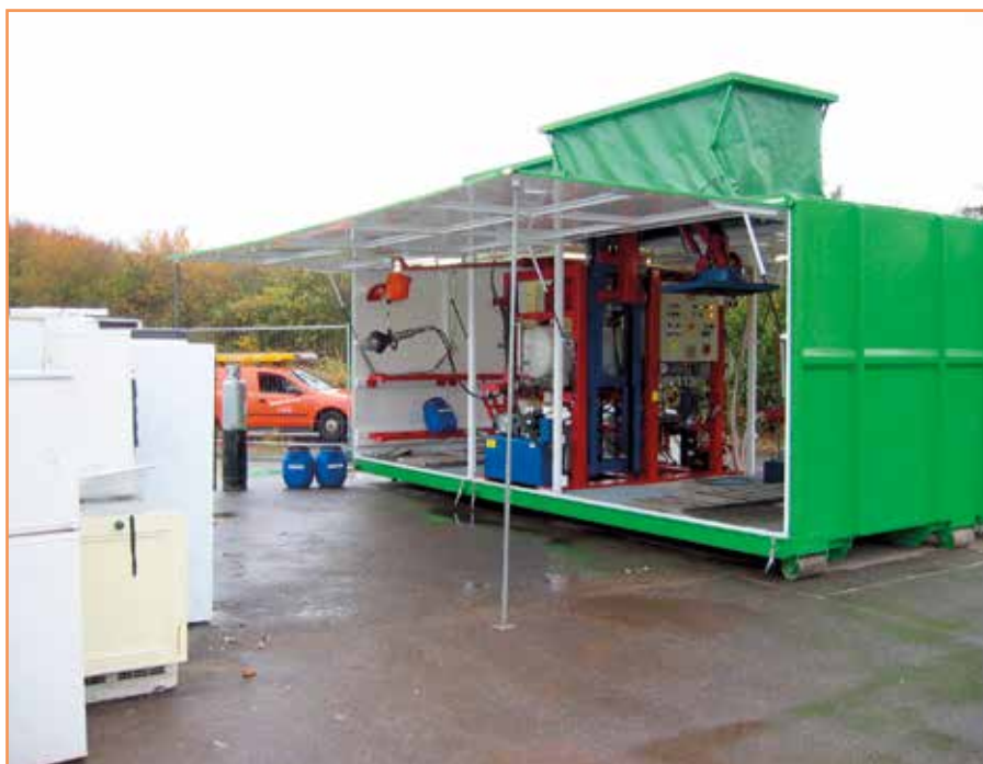
Фото 4. Первый этап переработки холодильников: освобождение и удаление контуров охлаждения
