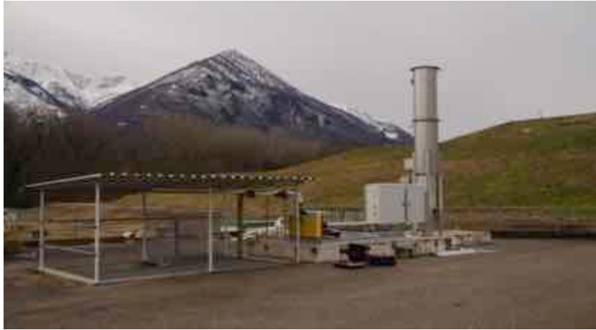
Небольшая компактная установка дегазации, 300 м 3 /ч, рамная конструкция, ВТ сжигание на свече, озелененный полигон (правая сторона)
