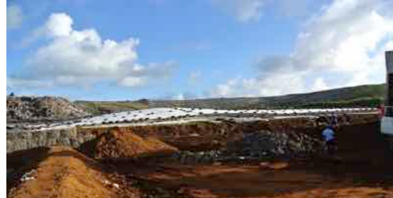
Специализированный полигон, отходы, захороненные слоями, защита поверхности земли
