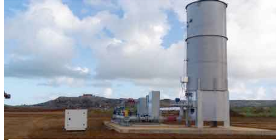
Установка дегазации среднего размера, 2000 м 3 /ч, рамная конструкция, ВТ сжигание на свече, работающий полигон (задний план)
